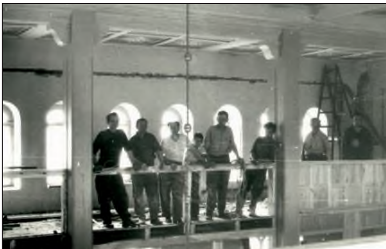
Rok 1967. Prace remontowe na balkonach kościoła.
