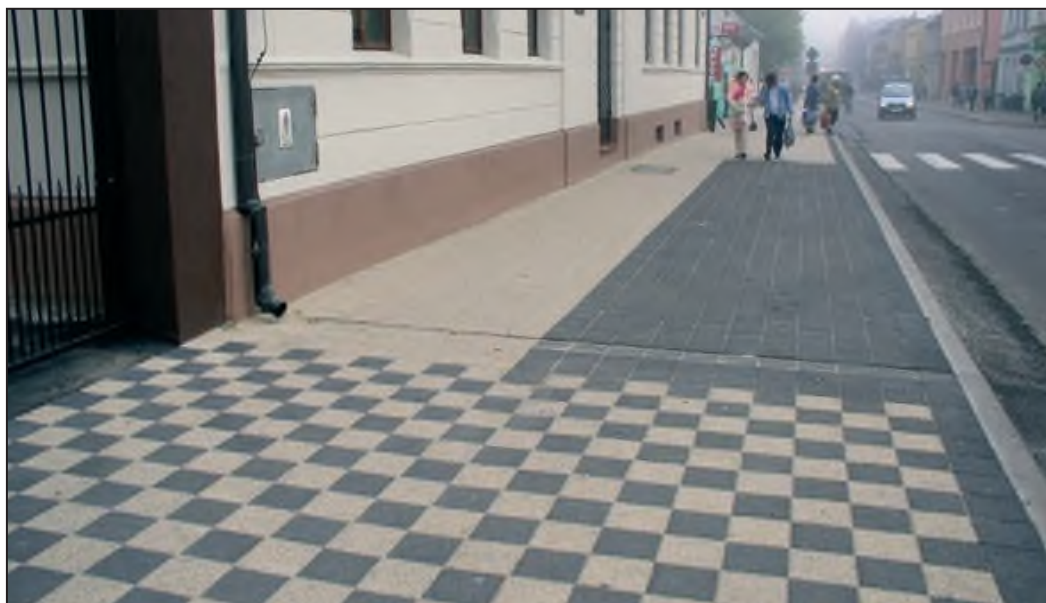
Ulica Poznańska po remoncie. W głębi Muzeum Regionalne z odnowioną elewacją.
