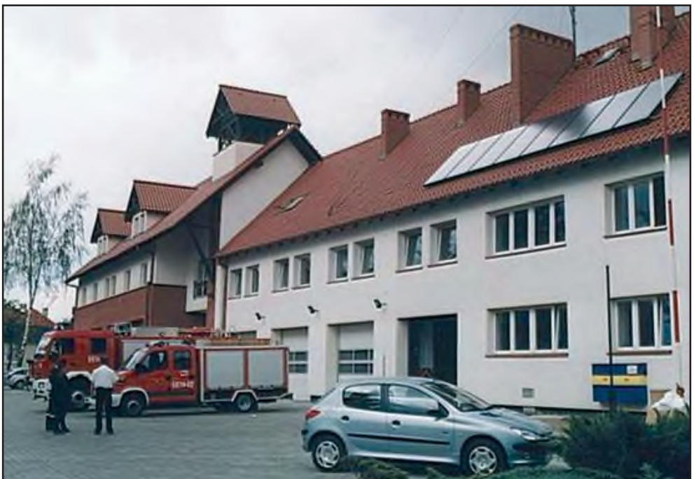
Budynek Powiatowej Straży Pożarnej po przebudowie i rozbudowie.
