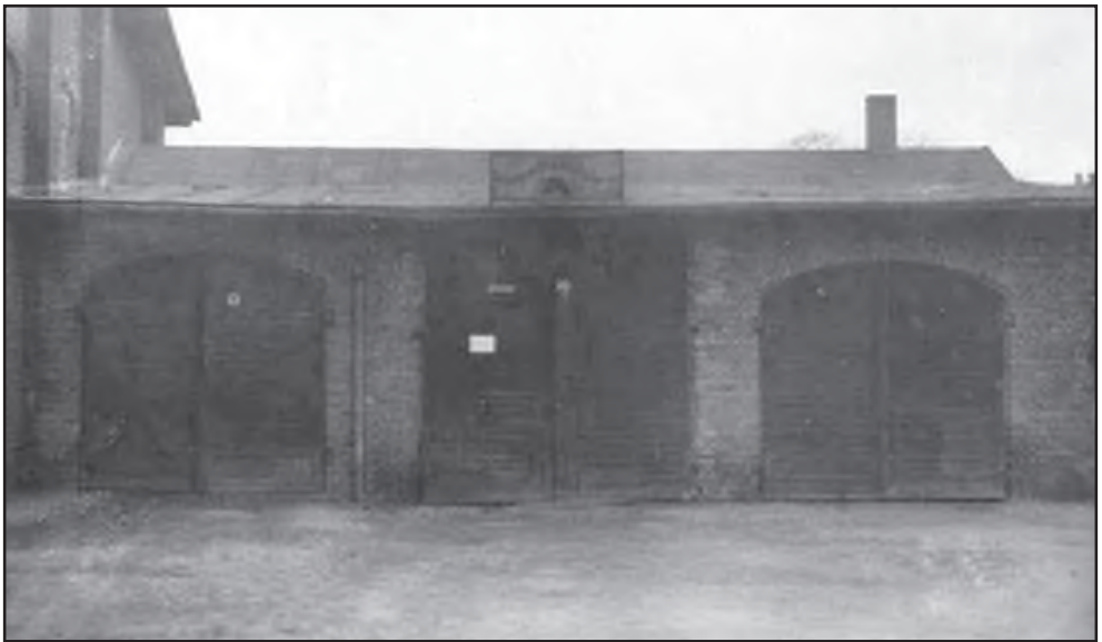
Pomieszczenia garażowe Straży przy Pl. Kościuszki (rok 1956).
