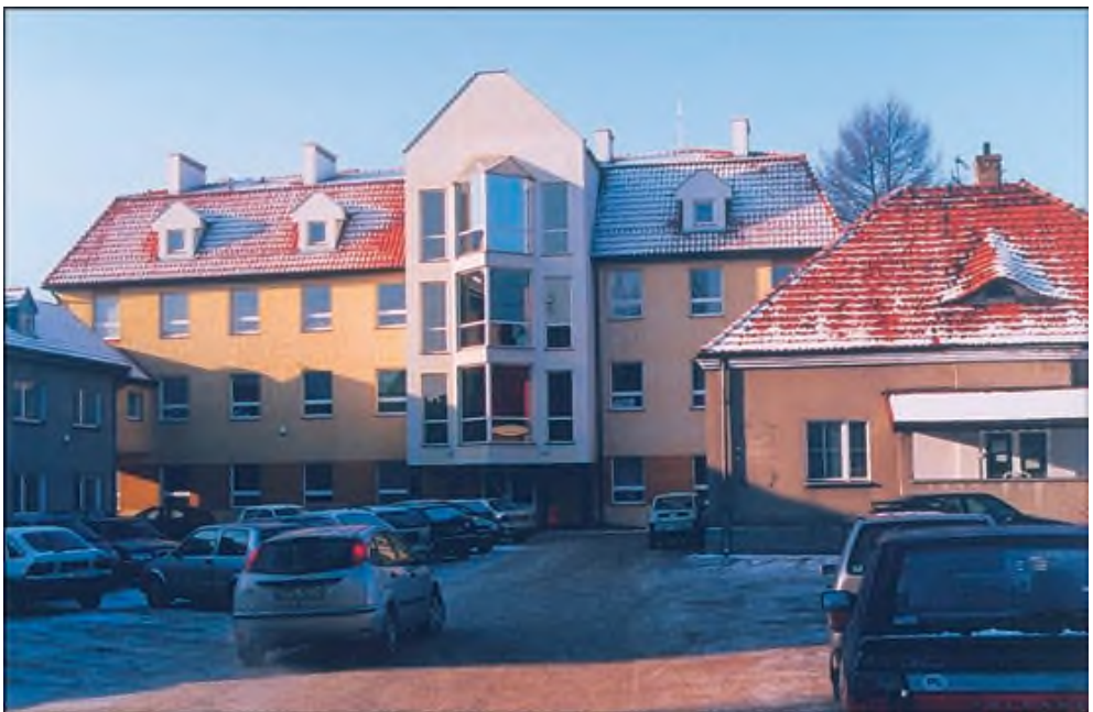
Nowy budynek Starostwa przy ul. Poznańskiej 79.
