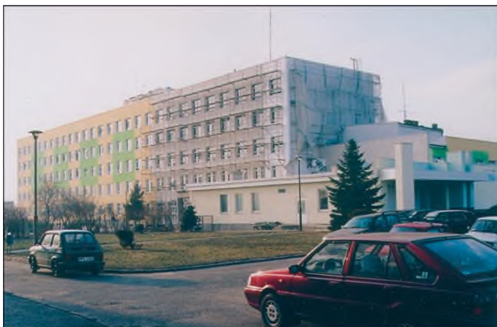
Remont Szpitala - grudzień 2002
