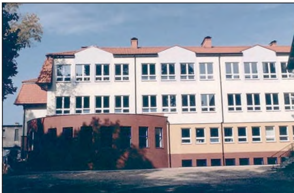
Nowy budynek Zespołu Szkół Publicznych nr 2 przy ul. Ogrodowej. Widok z Parku Miejskiego.
