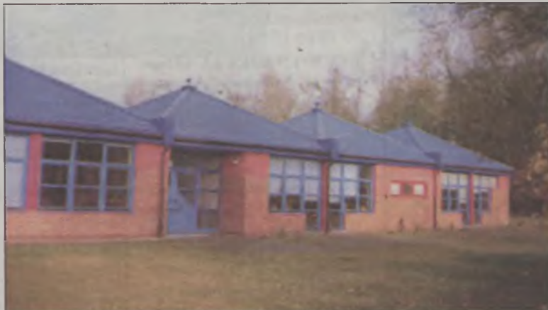
Tak wyglądała będzie szkoła w Tokarach z zewnątrz...
