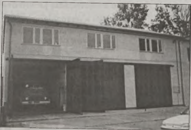
Nowa elewacja strażnicy
