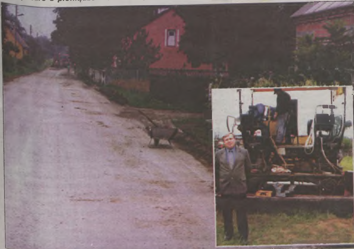
Czy na budowie tej drogi w Rudzie przewodniczący zyskał 5 tysięcy złotych?
