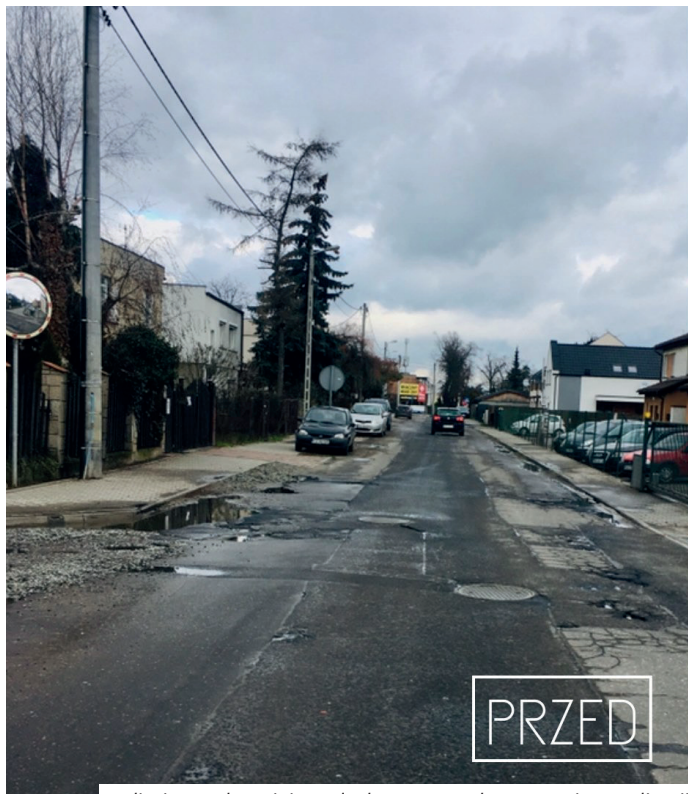
Zdjęcie przedstawiające ul. Klonową przed rozpoczęciem realizacji
