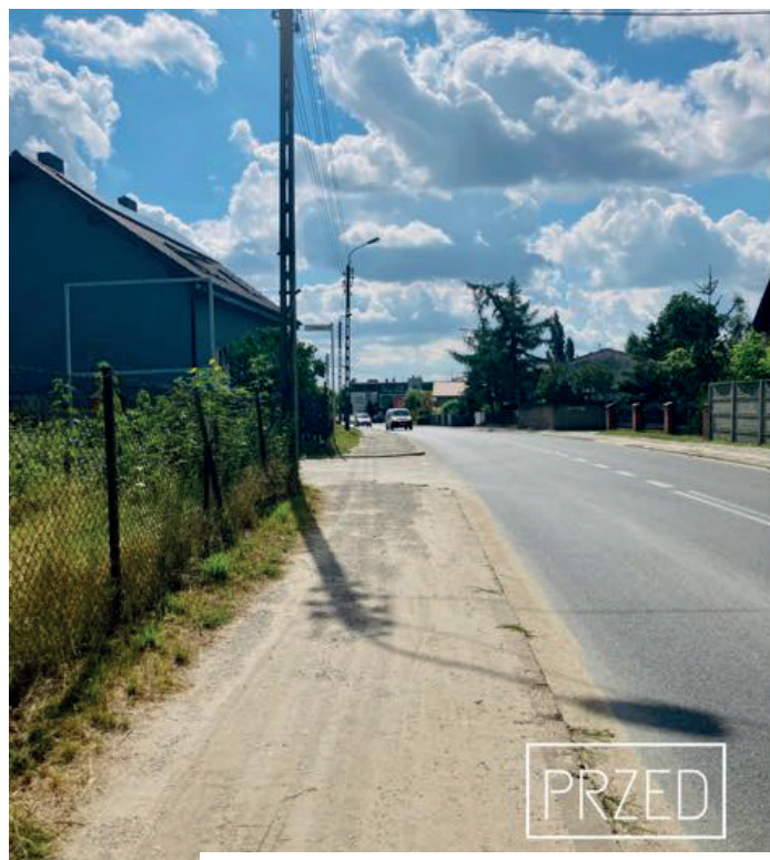
Zdjęcie przedstawiające chodnik w ul. Jana III Sobieskiego przed rozpoczęciem realizacji
