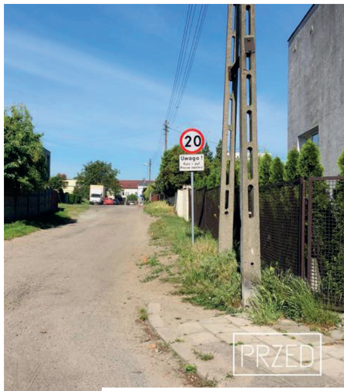
Zdjęcie przedstawiające chodnik w ul. Orzechowej przed rozpoczęciem realizacji
