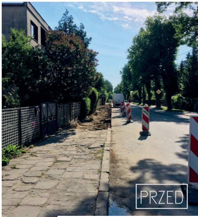
Zdjęcie przedstawiające chodnik w ul. Wojska Polskiego przed rozpoczęciem realizacji
