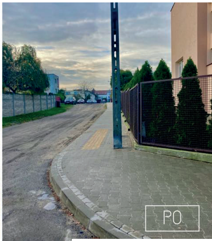
Zdjęcie przedstawiające chodnik w ul. Orzechowej po zakończonej realizacji
