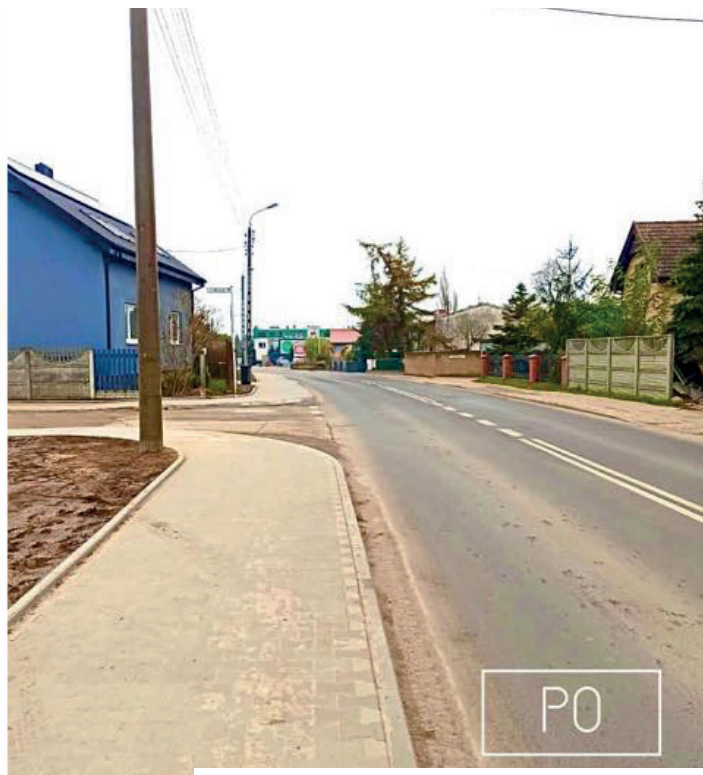
Zdjęcie przedstawiające chodnik w ul. Jana III Sobieskiego po zakończonej realizacji
