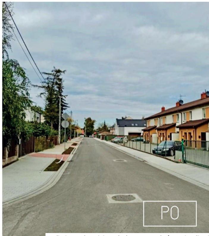
Zdjęcie przedstawiające ul. Klonową po zakończonej realizacji
