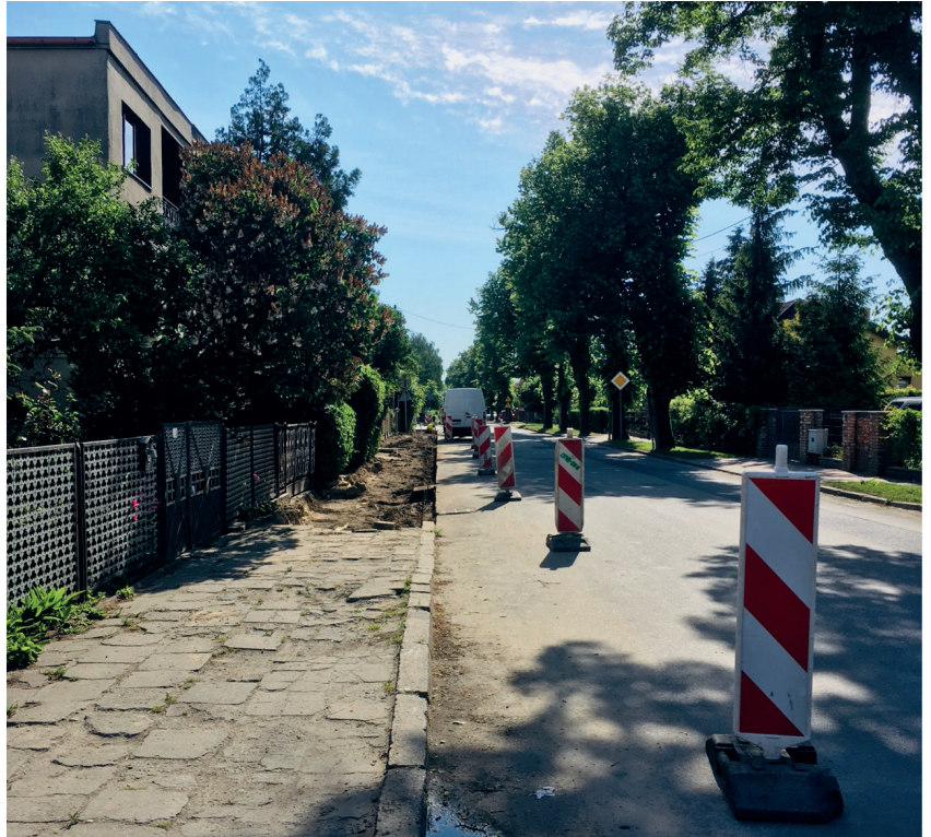
Przebudowa chodnika w ciągu ul. Wojska Polskiego, na odcinku od ul. Szkolnej do ul. Traugutta
