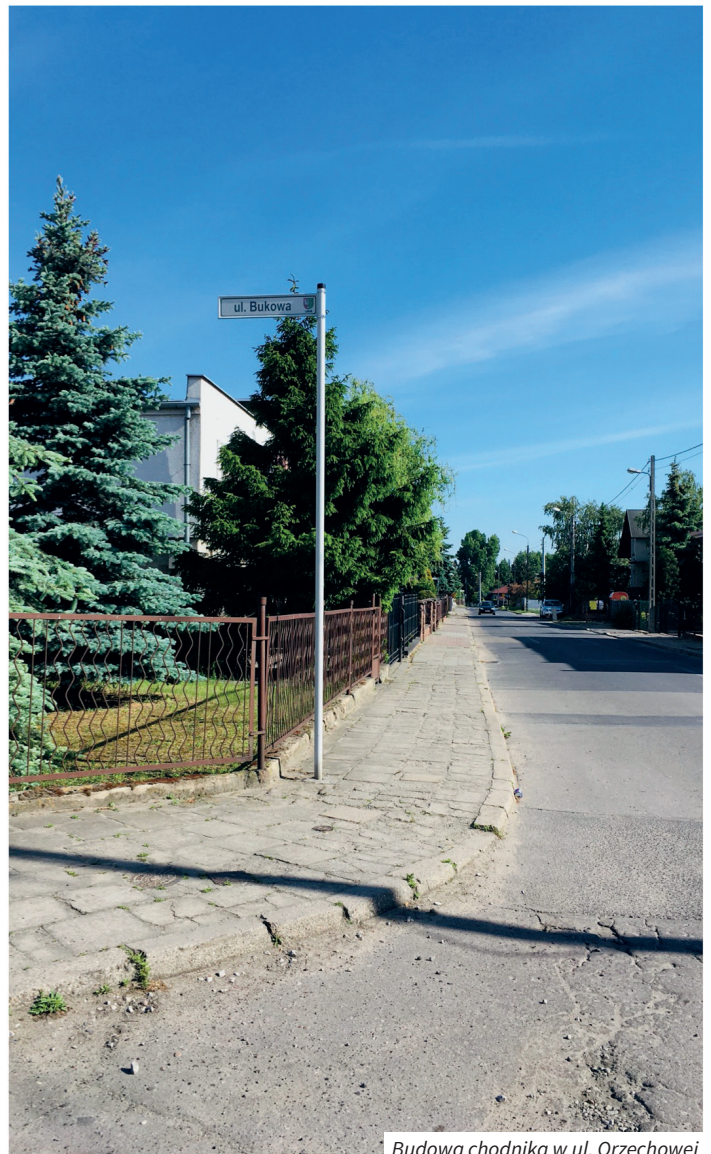
Budowa chodnika w ul. Orzechowej
