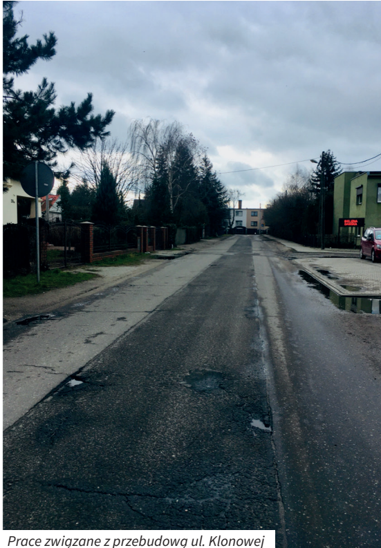
Prace związane z przebudową ul. Klonowej
