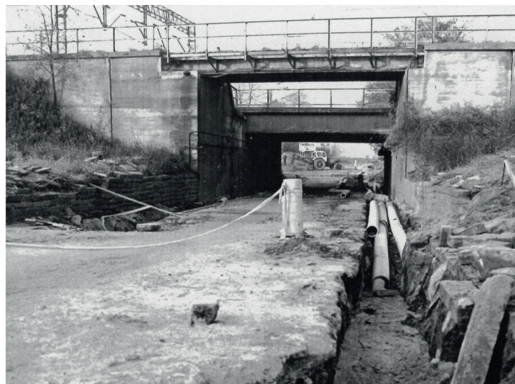
Wiadukt ulica Powstańców Wlkp., fot. archiwum UML
