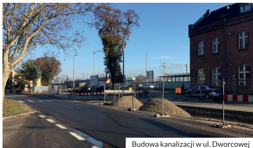
Budowa odcinka ul. Wschodniej
