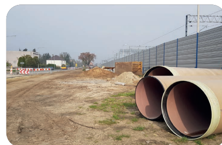
3. Inwestycja na ul. Dworcowej
