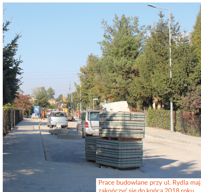
Trwają prace przy budowie ul. Dojazdowej
