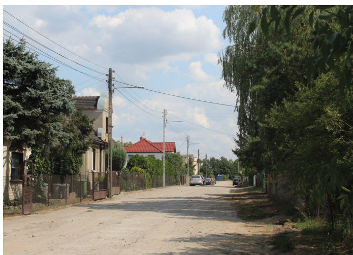
Budowa chodnika przy ul. Podgórnej rozpocznie się w październiku.
