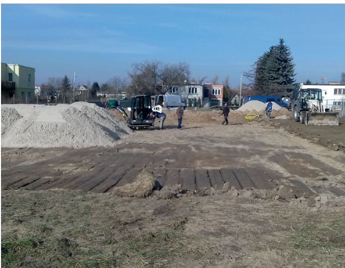
Przygotowanie do instalacji odwodnienia na boisku
