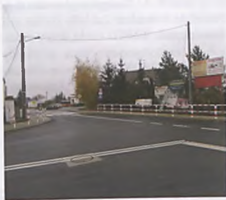
Zakończenie budowy ulic zostało zgłoszone u Powiatowego Inspektora Nadzoru Budowlanego
