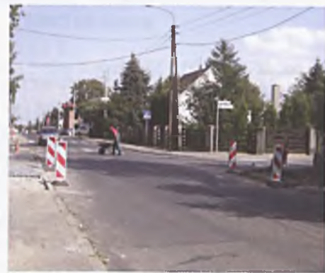
Budowa przejścia dla pieszych przy skrzyżowaniu ulic Kollątaja i 11 Listopada
