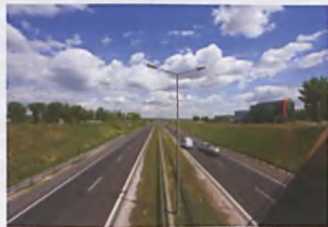
W styczniu 2015 rozpocznie się budowa 3 pasa autostrady
