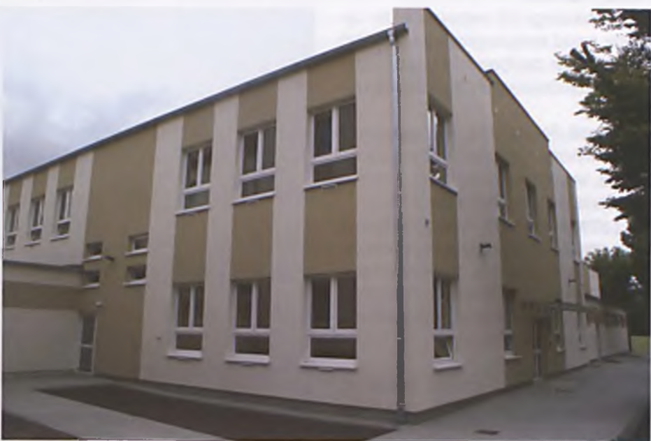
Inwestycje: rozbudowa budynku szkoły SP1
