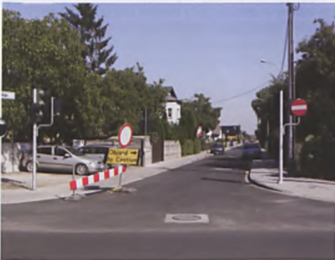
Układanie nawierzchni jezdni i chodników na ul. 1 Maja
