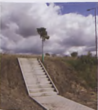
Schody z ul. Unijnej na osiedle
