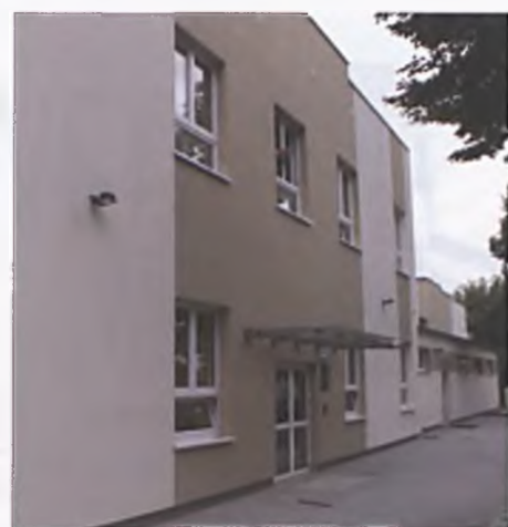
Nowe skrzydło budynku SP1
