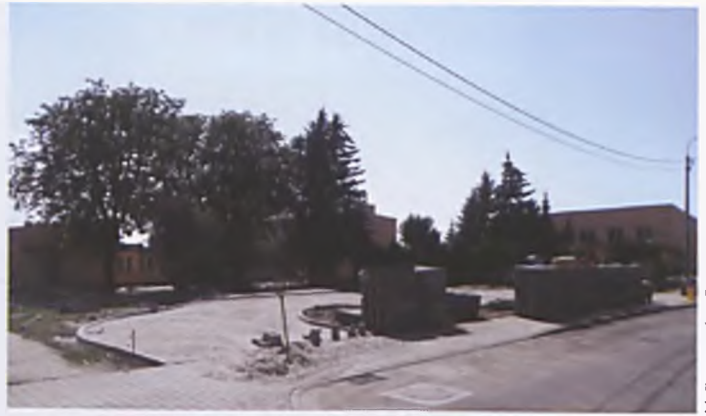
Układanie nawierzchni jezdni i chodników na ul. 1 Maja
