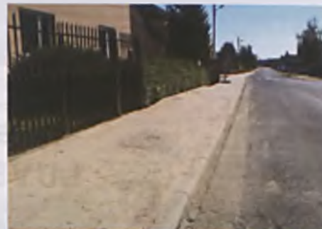
Budowa chodnika przy ul. Szkolnej
