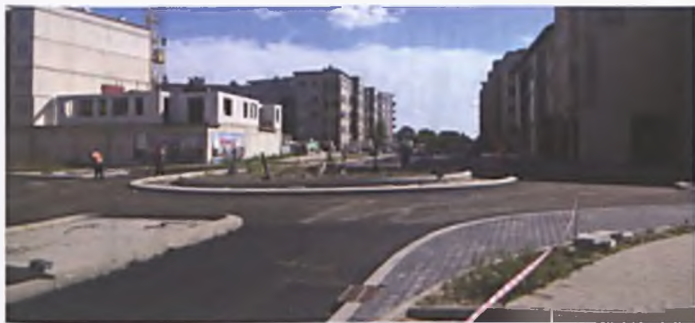
Budowa ul. Wschodniej
