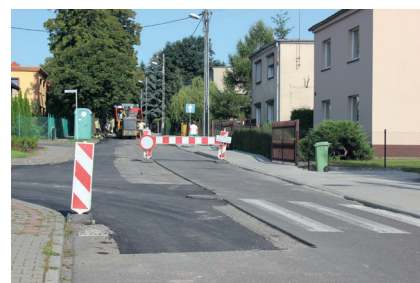
Prace przy ul. Szkolnej
