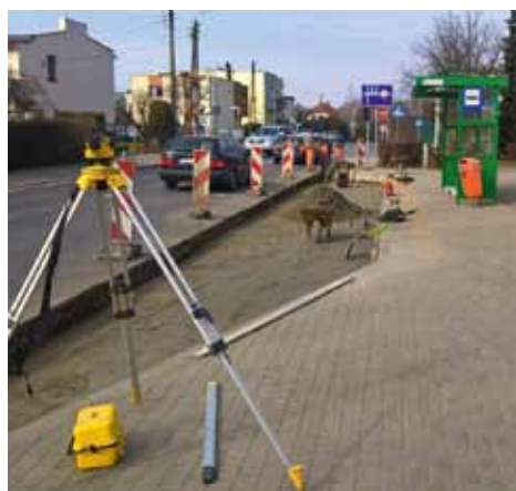
Remont zatoki autobusowej przy ul. Streicha
