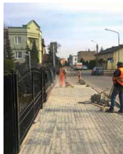
Remont ul. Dąbrowskiego
