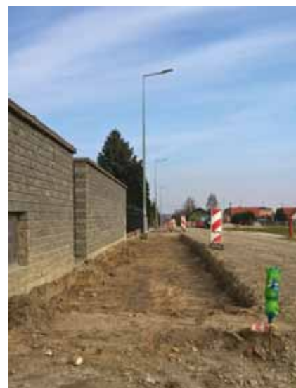
Budowa ul. Malwowej
