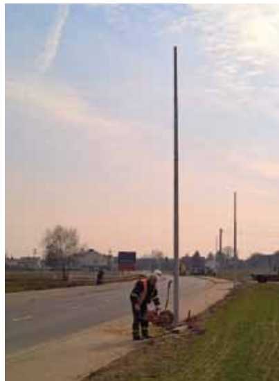
Budowa oświetlenia w porozumieniu ze spółką Eneos
