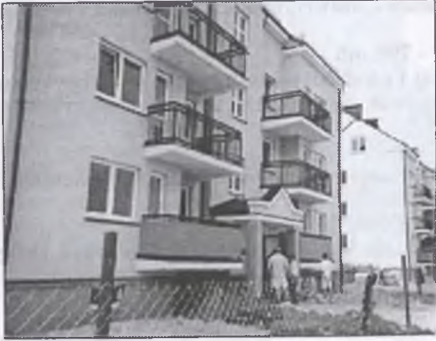
W Krośnie, w ciągu 11 miesięcy zbudowano 4 bloki mieszkalne, w których zamieszkały 44 rodziny. Powstaje już kolejnych 48 mieszkań, do zamieszkania pod koniec przyszłego roku
