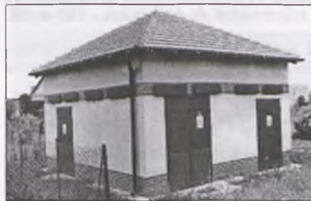
Wzrasta liczba trafostacji. Gmina wspierała finansowo komitety elektryfikacji. W Pecnej, Rogalinie, Krosinku i Wiórku położono linie kablowe do zasilania oświetlenia a w Radzewicach ustawiono słup liniowy
