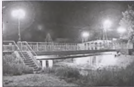
W ciągu czterech lat, w ramach modernizacji oświetlenia ulicznego założono w gminie prawie 300 lamp. Większe inwestycje to oświetlenie mostu na ul. Niezłomnych (na zdjęciu) i skrzyżowania w Dymaczewie Nowym
