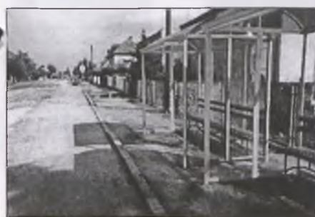
Na terenie całej Gminy ustawiono 22 wiaty przystankowe. Chronią pasażerów przed deszczem i wiatrem
