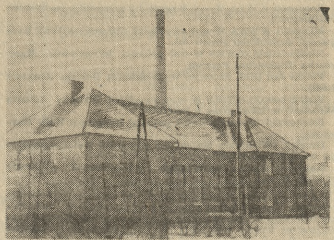
Sulmierzyce, to małe miasteczko w pow. krotoszyńskim. Istnieją tu poważne rezerwy robocze. I produkcyjne też. Ten budynek (wzniesiony w 1938 r.), to nieczynna elektrownia (miasto podłączono do linii wysokie napięcia). Można i trzeba go wykorzystać. Ale Miejska Rada Narodowa Sulmierzyce sama tego problemu nie rozwiąże. A WKPG na próżno szuka od lat użytkownika dla tego obiektu...
