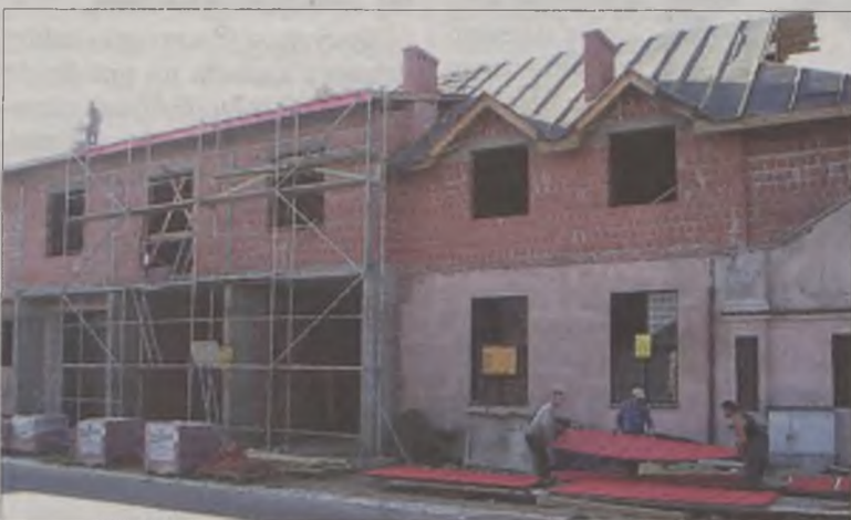
Na budowie remizy
