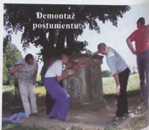
Demontaż figury na dźwig
