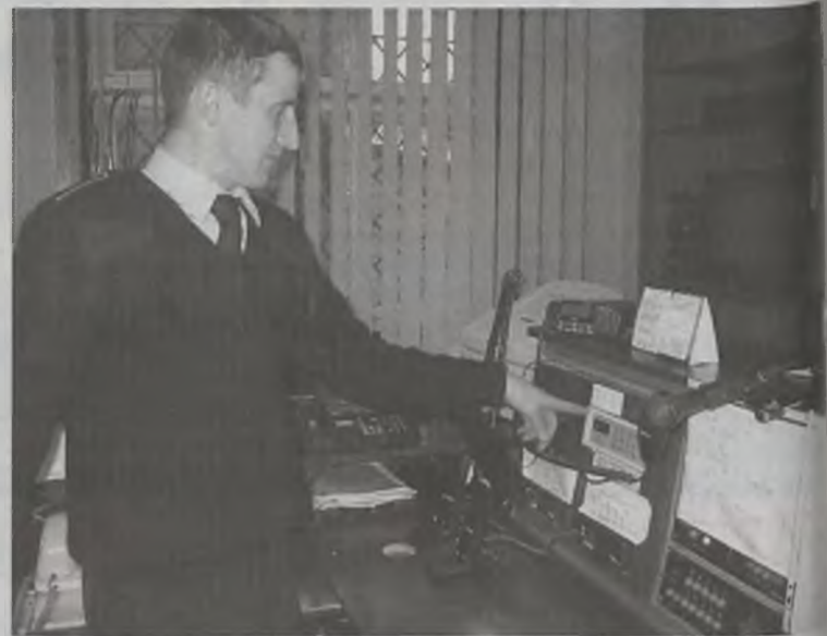
Aspirant Remigiusz Rosiak prezentuje działanie systemu alarmowania selektywnego. To urządzenie, dzięki któremu w centrali w Turku można włączyć syreny alarmowe w wybranych jednostkach OSP w powiecie tureckim.
