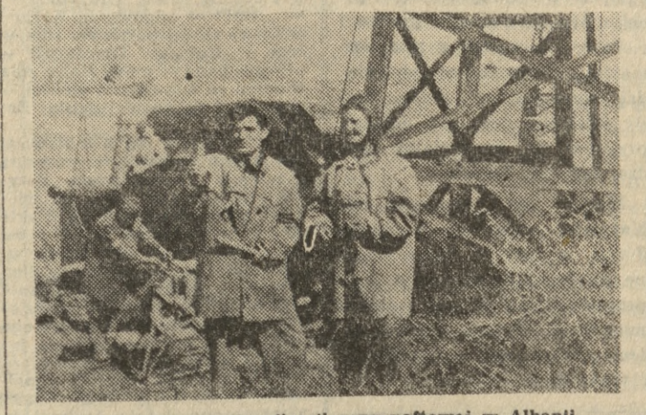
Budowa nowoczesnej rafinerii ropy naftowej w Albani. Fot. — CAF
