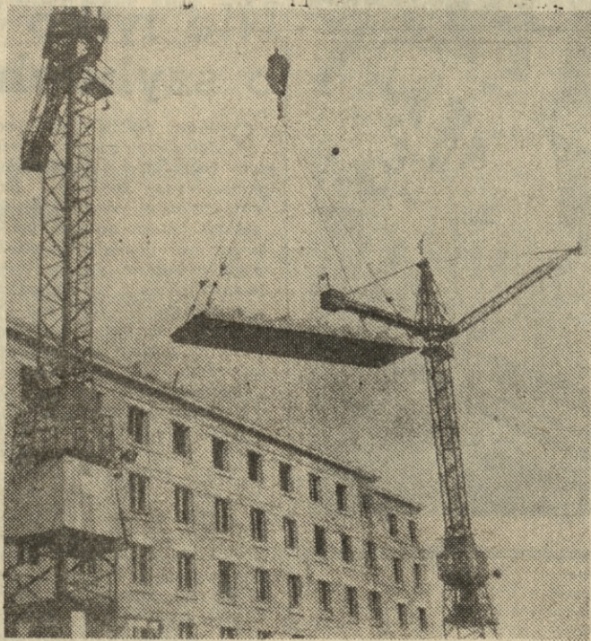
Budowa metodą przemysłową na Osiedlu Sielce w Warszawie. Przy budowie 2 bloków mieszkalnych na osiedlu Sielce zastosowano elementy prefabrykowane: stropy okienne, podesty do schodów, schody. Na zdjęciu: budowa metodą przemysłową bloku nr 85. Będzie on wykonany 30 października.
