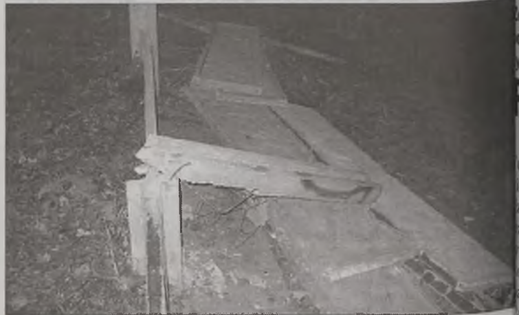
Nieznani wandalę regularnie niszczą ogrodzenie szkolne
