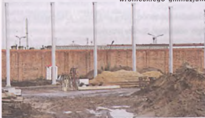
Budowa hali sportowej na boisku szkolnym wronieckiego gimnazjum
