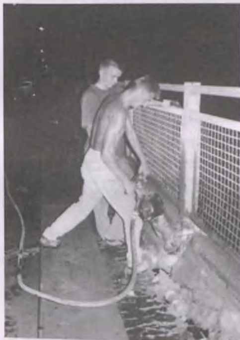
Robotnicy pracują nawet niedzielami - na dwie zmiany, ale bywa że i nocą.
