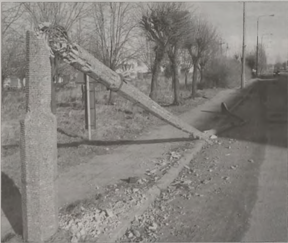
Oslabiona konstrukcja lampy mogła być przyczyną tragedii na ulicy Milewskiego
