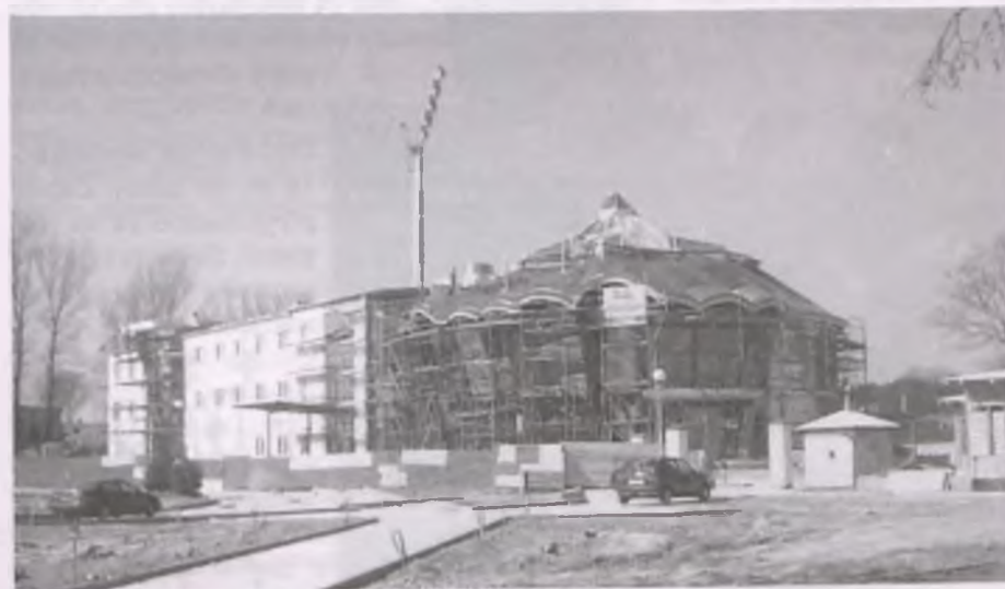
Tymczasem na stadionie trwa budowa wyrzutowego obiektu hotelowo - socjalnego.
