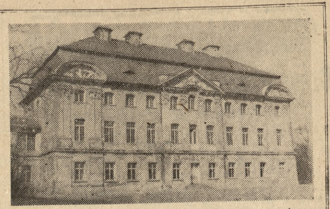
Oto dom, w którym mieszkała przed wojną jedna osoba — „pani” na Czajeniu” hrabina Gerlicz. Dziś b. pałac obszarnczy służy celom szkolnictwa podstawowego. — Jeszcze tylko — mówi kierownik szkoły ob. Nowak — zelektryfikowanie, zradiofonizowanie, zainstalowanie centralnego ogrzewania i nasza szkoła zrówna się z wielkomejską. Inwestycje te będą przeprowadzone w okresie realizacji planu 6-letniego. Fot. Zb. Bernacki
