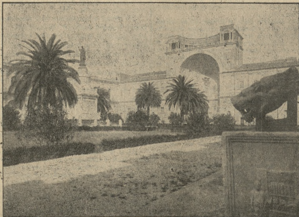
„Podwórze Szyszki” (Cortile della Pigna) z olbrzymią niszą, zbudowaną przez Bramantę
