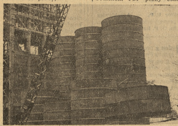
Montaż silosów do nasion olejnych
