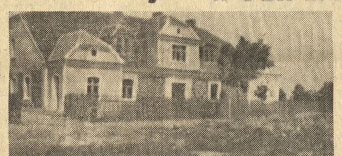
I w tym czworoku w maj, Grabowiec, przebudowanym gruntownie w roku bieżącym otrzymali robotnicy piękne mieszkania
