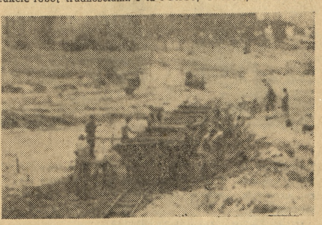
Junacy z 4 kompanii 22 brygady „SP“ zatrudnieni przy robotach ziemnych na Malcie zdobyli proporcję przodowników i nie wypuszczają go ze swych rąk. Widzimy ich przy pogłębianiu dna przyszłego jeziora
