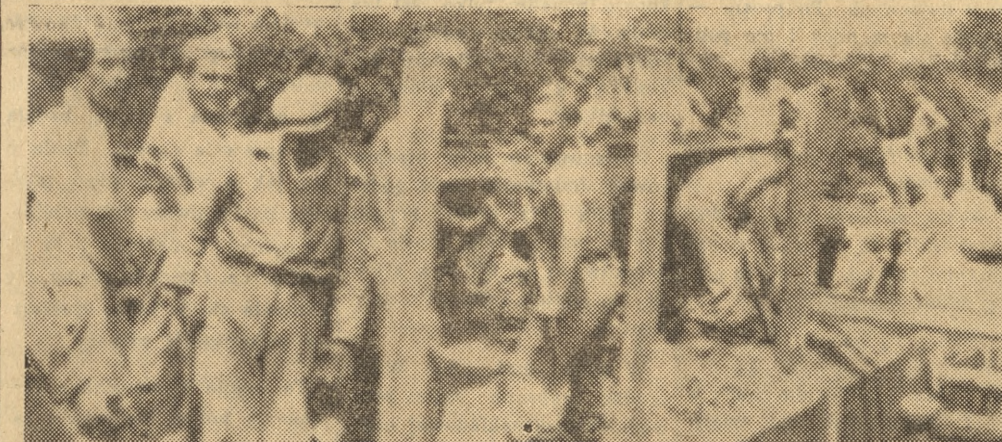
Junacy 22 brygady po większej części uczniowie częstochowskich szkół dzielnie spisują się przy budowie kolektora prawnobrzeżnego. Widzimy ich przy załadowywaniu ziemi na wózki
