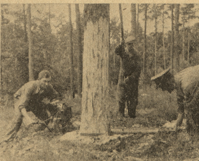
Ścinanie w lasach Nadleśnictwa Rychlik, pow. Trzcianka, przy pomocy mechanicznej piły łańcuchowej o napędzie benzynowym. Jest to ciężki typ piły — lżejszymi i spokojniej pracującymi okazały się piły elektryczne, wypróbowane podczas pokazu w ub. piątek i sobotę.
