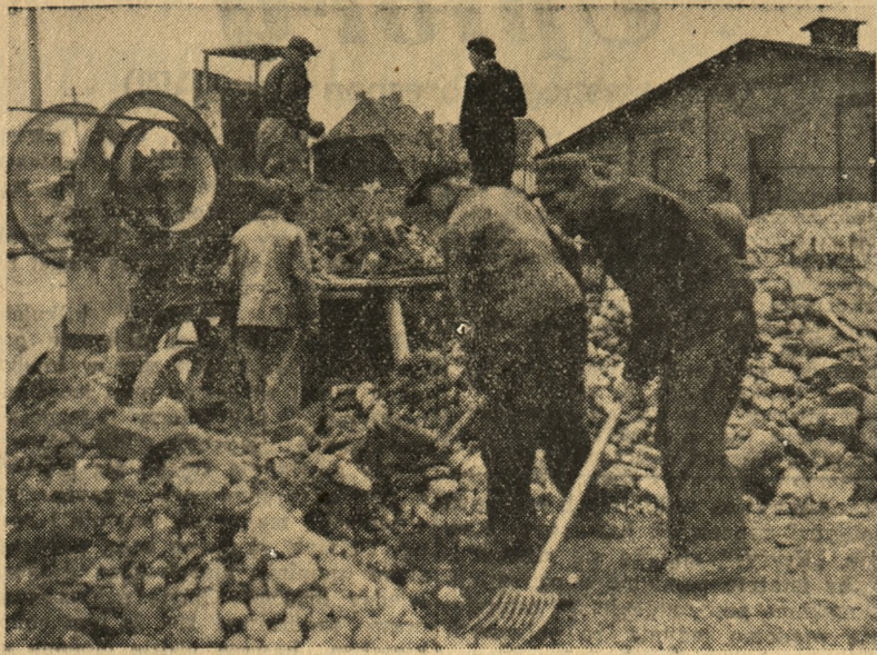
Nasi drogowcy dzielnie splewają się na drogach. Budują nowe odcinki szos, przebrukują i naprawiają nawierzchnie, wierzą przepusty, zakładają zieleńce... Oto grupa robotników Pow. Zarządu Drogowego w Zninie przy automatycznej tłuczkarce.
