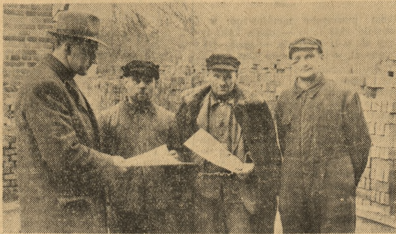
PAROWA CEGIELNIA RADZULA
