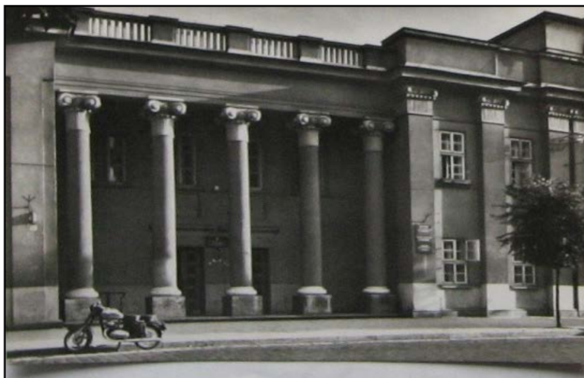
Fot. Wejście do hali sportowej w Przemyślu (zbiory L. Lassota)
