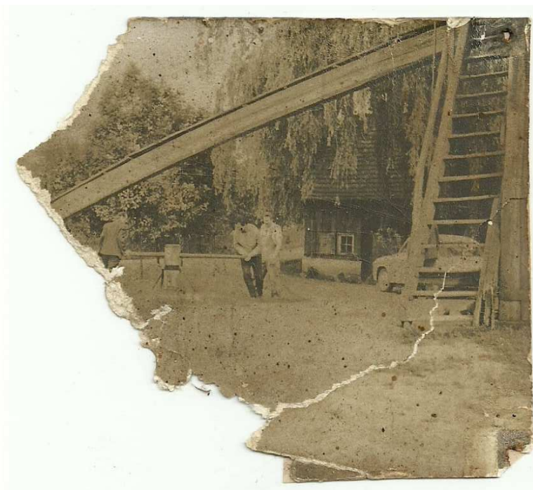
Fot. 4 - prawdopodobnie ok. 1960 r.; nastawianie budynku wiatraka do kierunku wiatru
