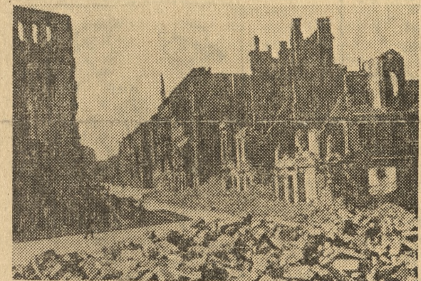
Cmentarzysko gruzów i kikuty zburzonych kamienic przy jednej z najbardziej zniszczonych ulic Poznania — ul. Pocztowej.
