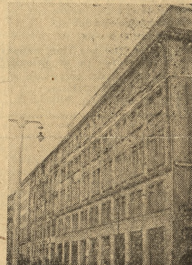
Nowocześnie wyremontowany i odbudowany gmach Zw. Rewizyjnych przy Placu Wolności. Okna zostały po wypaleniu budynku wskutek działań wojennych zupełnie przebudowane, a ostatnie piętro nadbudowane.
