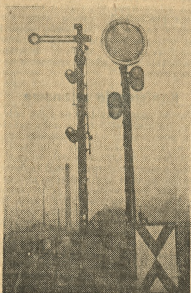
Oto jedna z bram wielkiego dworca — semafor. Opuszczone ramię zagradza drogę. Błada maszynie, gdy nie zatrzyma się przed sygnałem.
