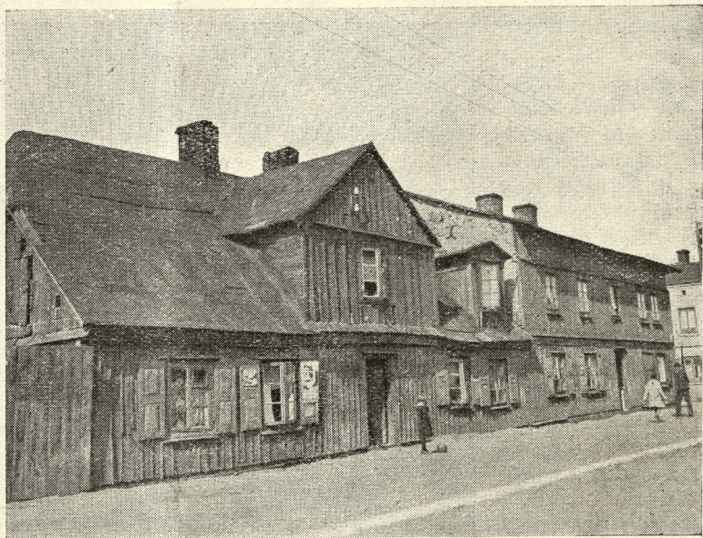
Domy mieszkalne w Żyrardowie.
