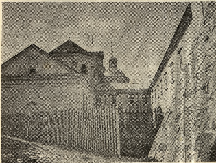
Klasztor i kościół w Podkamieniu.
