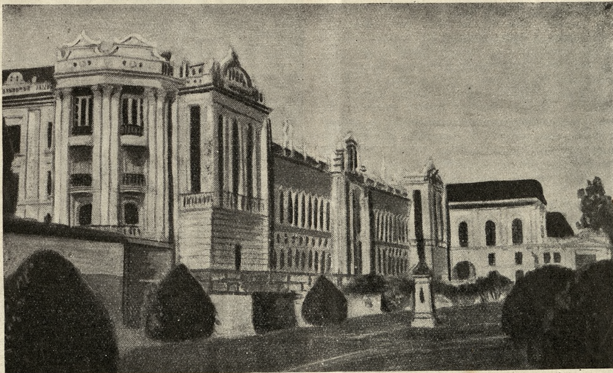
Pałac królewski w Khatmandu, który pogrzebał w swych gruzach dwie córki króla Nepalu oraz niezliczoną ilość służby i dworzan. Trzęsienie ziemi zniszczyło lewe skrzydło pałacu.
