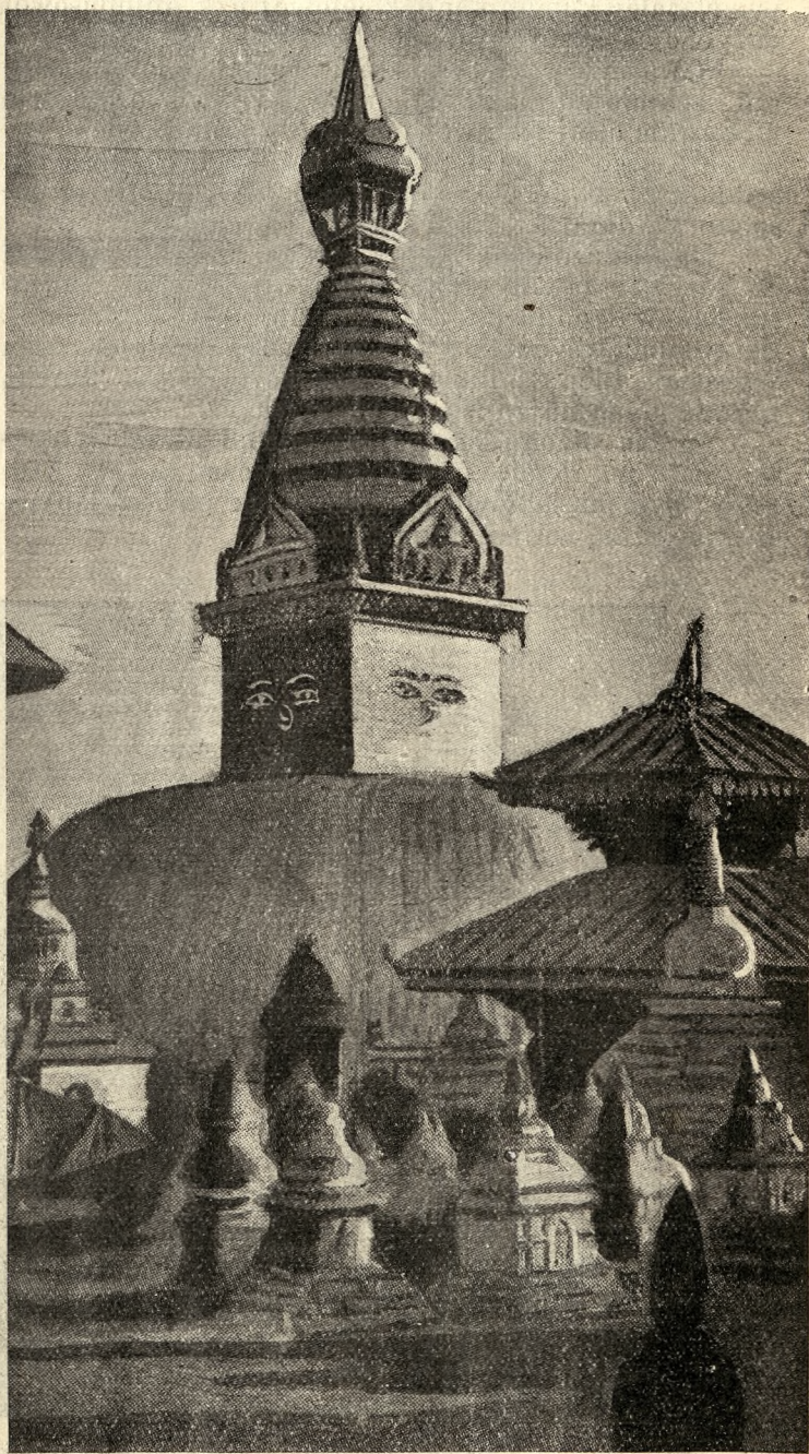
„Stupa“, słynnej świątyni buddyjskiej w Khatmandu, zniszczonej doszczętnie przez trzęsienie ziemi.
