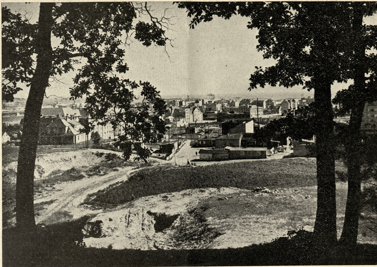
Widok na Gdynię
