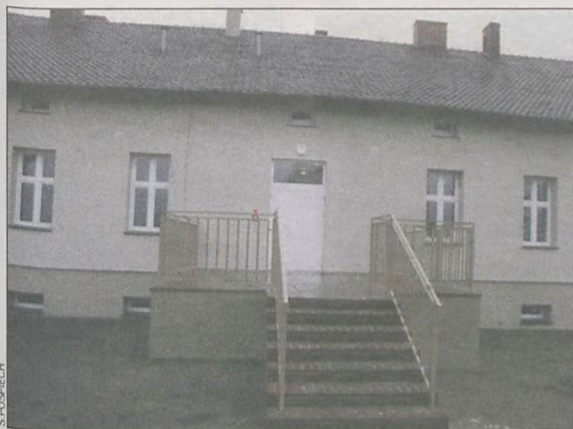
W budynku po przedszkolu utworzono 6 mieszkań socjalnych
