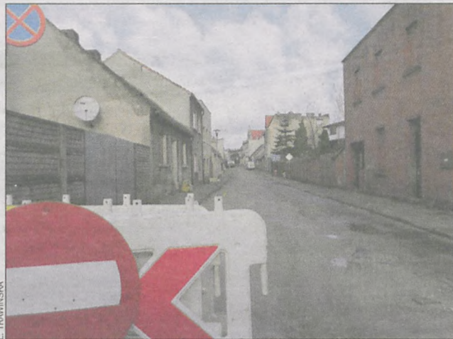
Prace na odcinku od Pleszewskiej do Szkolnej już wykonano
